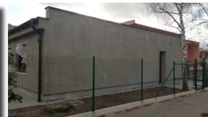
Dokončujeme stavbu domečku pro TOTEM Doubravka.
