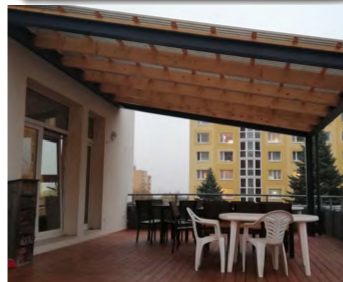
Zastřešení terasy TOTEM Bolevec, Kaznějovská 51.
